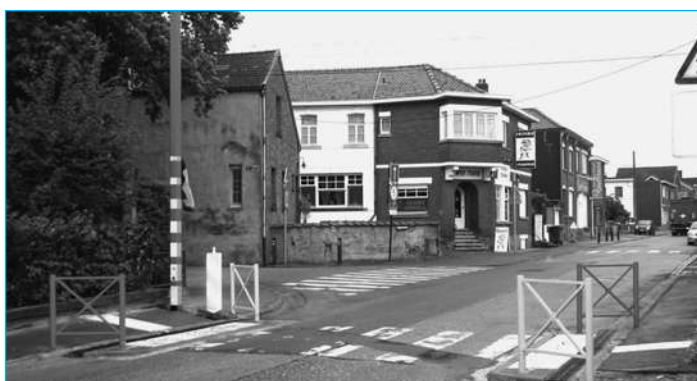
Réfection et égouttage des rues du Ruisseau et de Beaumont à Haccourt=>
