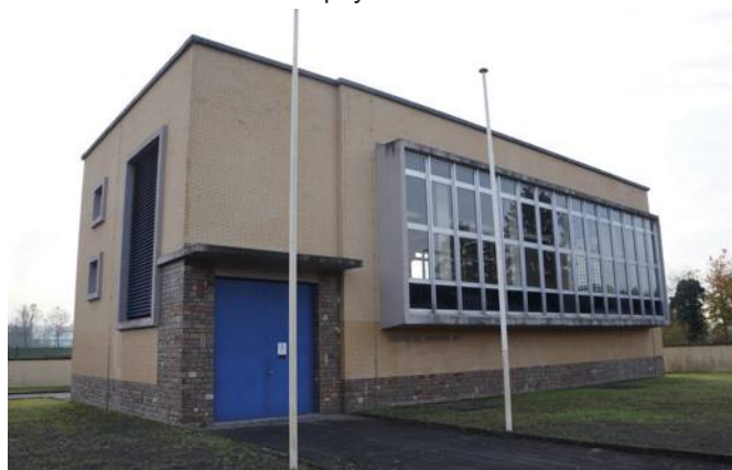
Station de pompage à Vivegnis
